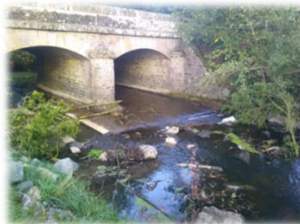
Ennoiement de l'échancrure du radier de pont
