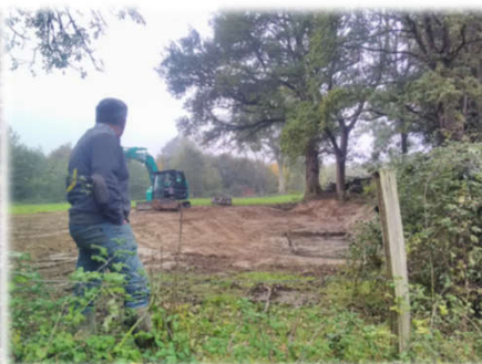
Curage de la mare avec reprofilage des berges
