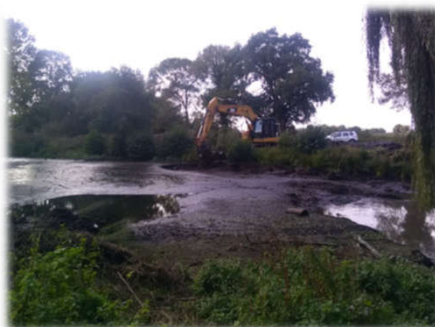
Curage de la mare avec réglage des vases dans les prairies du château
