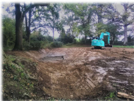
Curage de la mare avec reprofilage des berges
