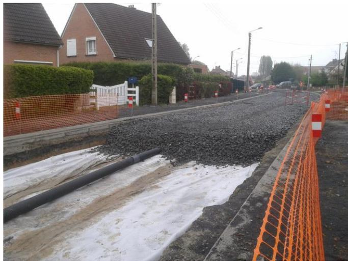
La chaussée à structure réservoir
