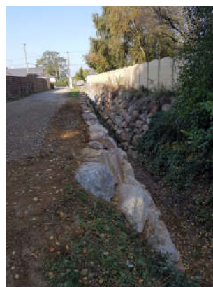
Sécurisation de la berge au niveau du virage du chemin d'accès à l'habitation, suite aux inondations du mois de juin 2018.
