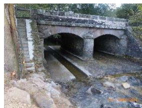
Echancrure réalisée dans le pont de la RD 81
