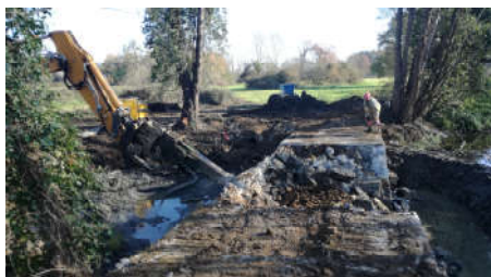
Démantèlement du clapet et du déversoir
