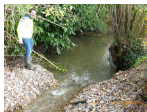
Réalisation de 3 radiers et effacement d'un seuil
